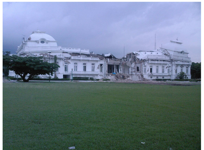
Le palais présidentiel effondré après le séisme
