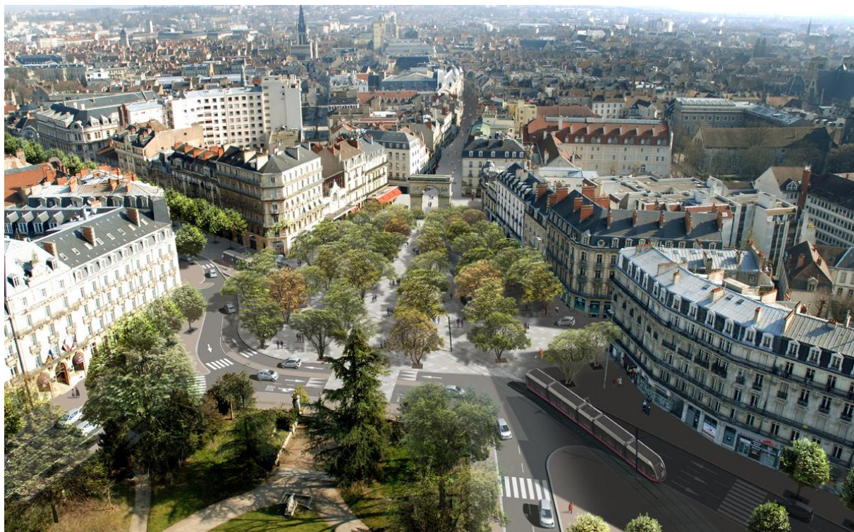
Réaménagement de la place Darcy (vue aérienne)
